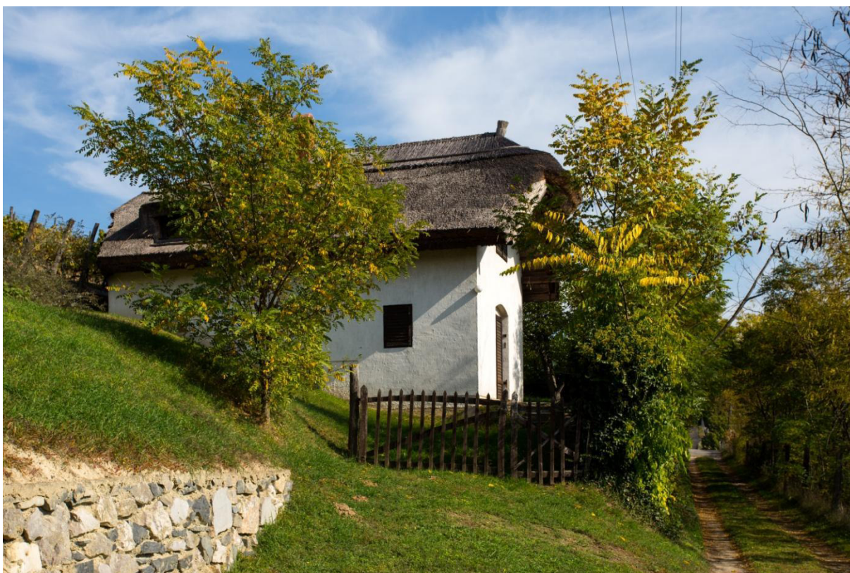
Karbantartott, hagyományos nádfedeles pince épület, léckerítéssel, nyílászárók esetében barna színhasználattal a szőlőhegyen.
