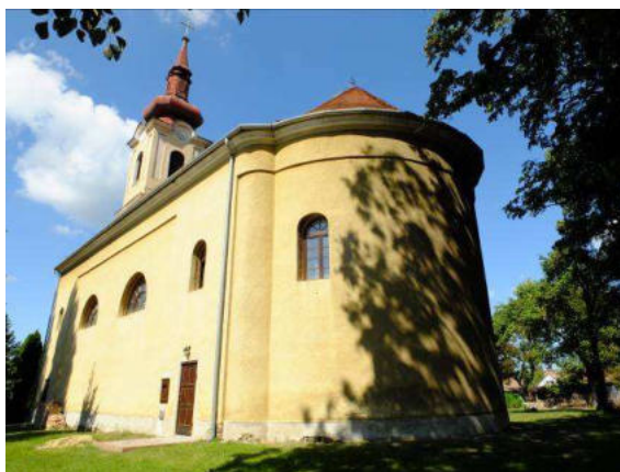
A 214/1 hrsz r. k. templom déli homlokzata
