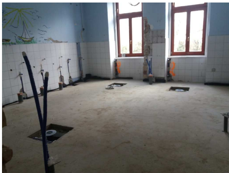
A gépészeti felállások elkészültek az aljzatbetonozással együtt
