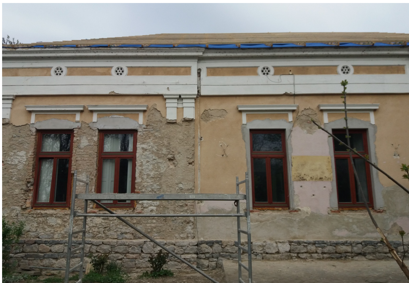
Lebontották a tetőt, megkezdődött a külső vakolat eltávolítása
