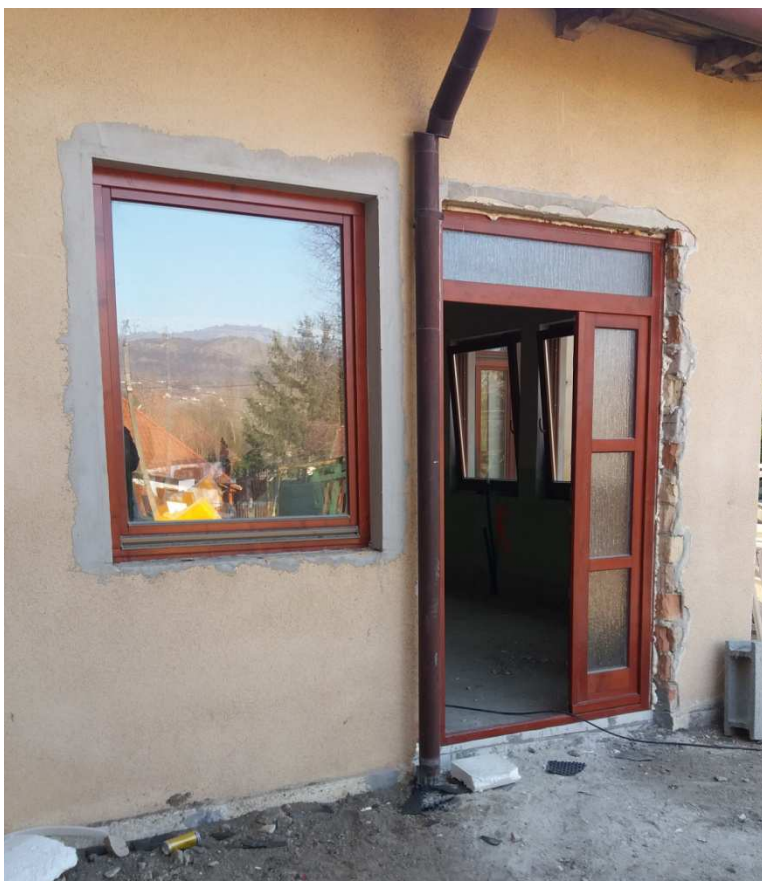
Megtörtént a nyílászárók áthelyezése
